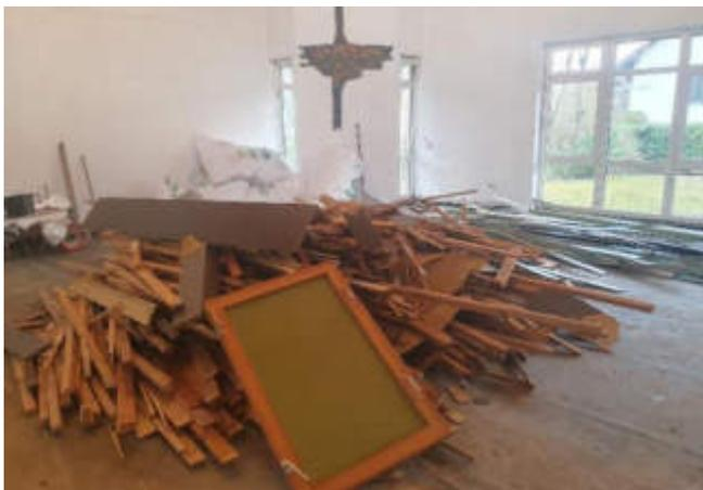
Mit Abbruch ging es auch weiter. Decken und grüne Faltschichten kamen raus, die Elektroinstallation konnte so auch besichtigt und einer ersten Prüfung unterzogen werden.
